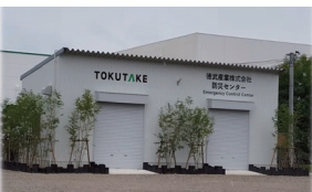
防災センター（2020年10月完成）
